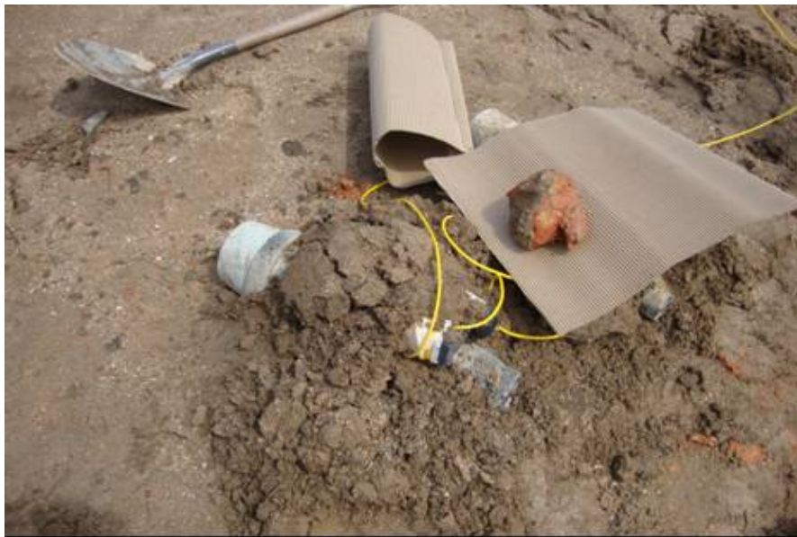
FIG 4-8 Processo de Detonação à Céu Aberto - Área de disposição - (Elaboração própria)
