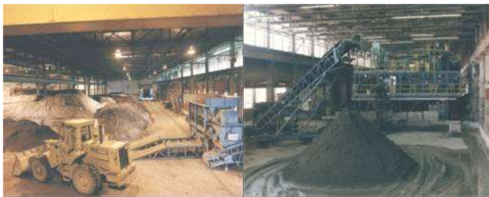
FIG 4-14 – Área de Armazenamento e Tratamento de Resíduos ( http://www.art-engineering.com/Projects/Montreal/Photos.htm [acesso 2008]).
