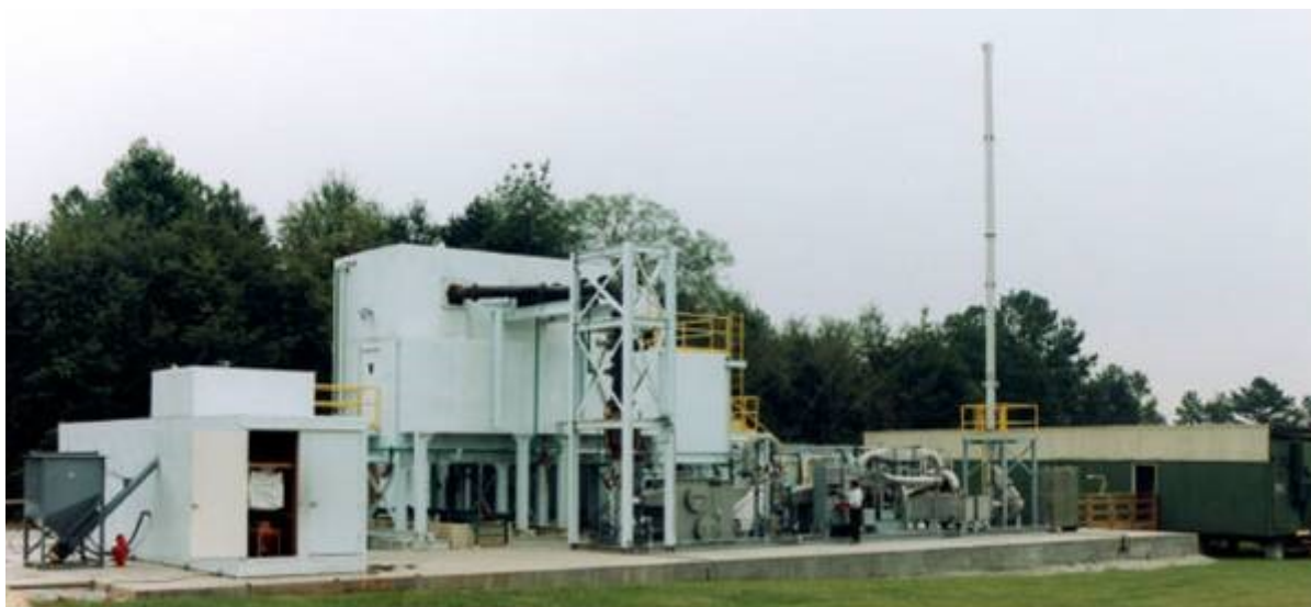
FIG 4-17 – Módulo de vitrificação transportado e instalado em campo - (SAVANNAH 2000).
