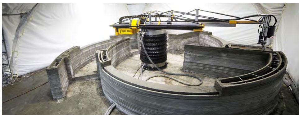
Figura 5 – Casa construída por manufatura aditiva (2)
