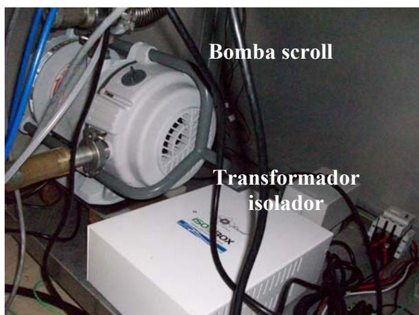
FIG.3.4 Fotografia da parte interna do rack, onde se pode ver a bomba do tipo scroll e o transformador isolador.
