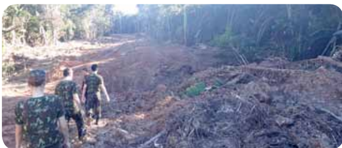
Alunos da Engenharia de Fortificação e Construção acompanharam as frentes de trabalho na região.
