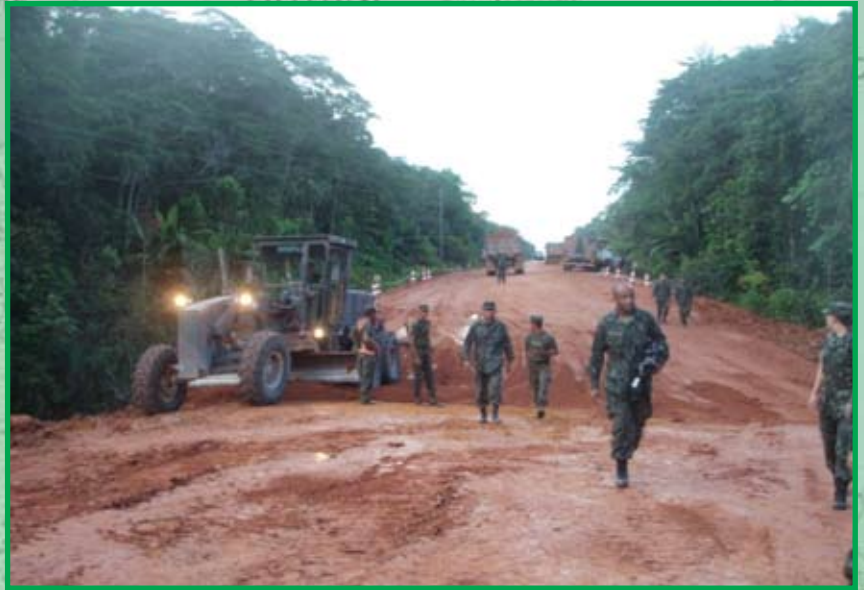
Obra de restauração da BR 319 em Beruri
